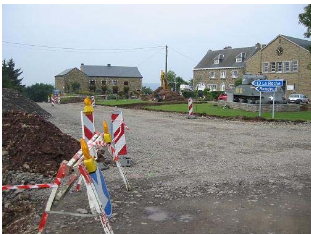
Arrachage de l'asphalte
