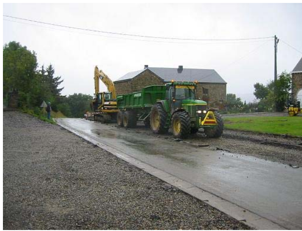
Arrachage de l'asphalte
