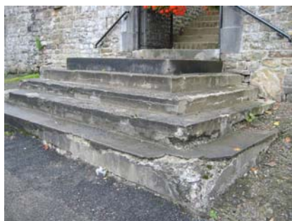
L'escalier vers l'église avant les travaux
