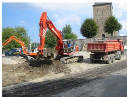
Vue du chantier
