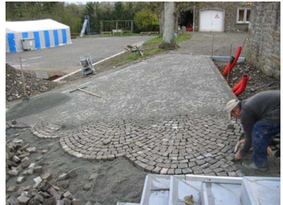
La pose des pavés
