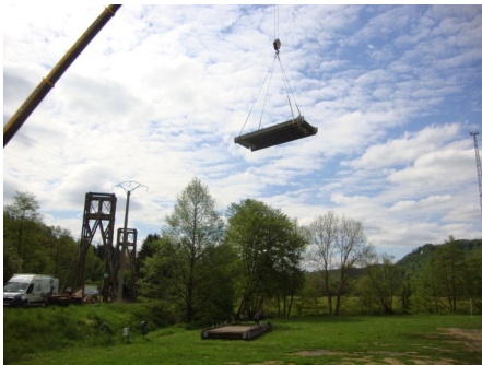
Enlèvement du tablier de la passerelle de Ronzon, avant son remplacement
