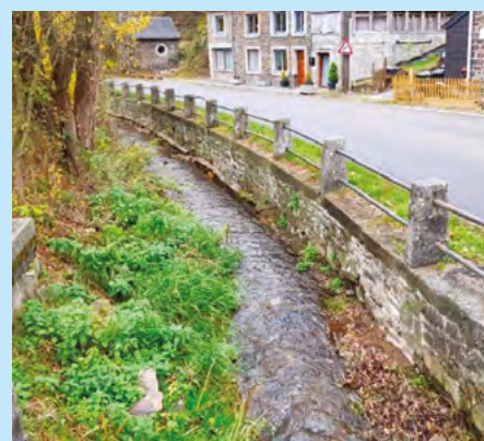
Traversée de Nohaipré après chantier. Dégagement de la végétation
