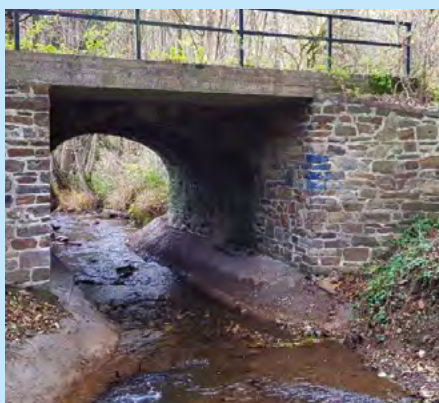
Ponceau de La Maladrerie après chantier, à Marcourt
