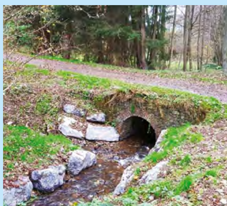
Le Donneux après chantier, à Marcouray
