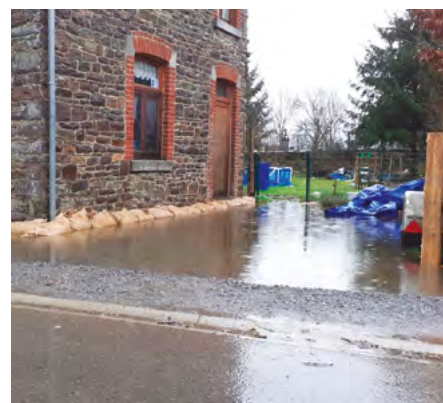
Protection d'une habitation à Rendeux-Bas
